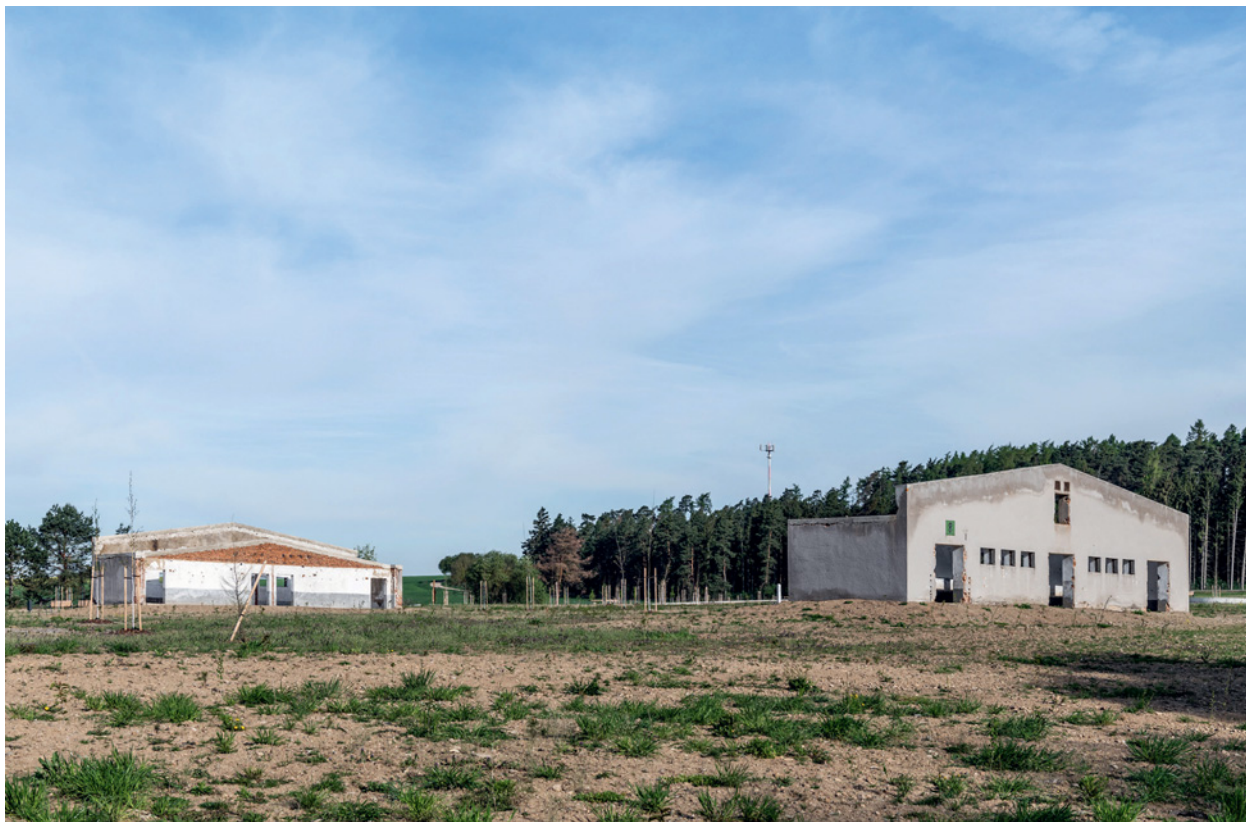
2 Z celkem třinácti hal bývalého vepřína, zrealizovaných ve třech etapách (1972, 1978 a 1985), které ve své době pojmuly až třináct tisíc prasat, byl zachován pouze fragment; mezi torzy průčelních zdí vede pěší stezka.
