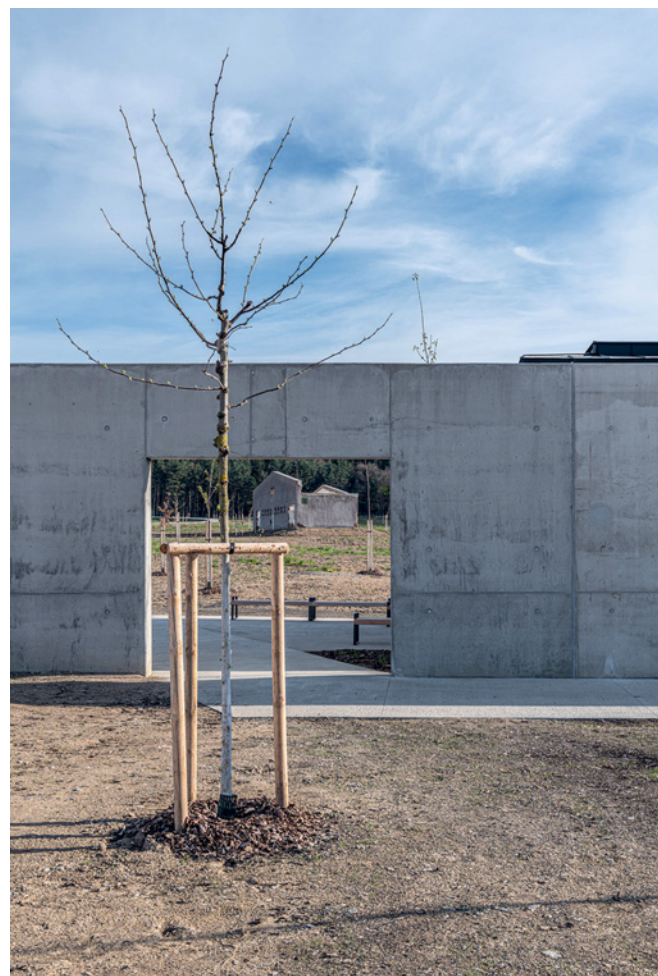
4 Betonová bariéra u vstupu do areálu navozuje pocit aktu segregace, po jejím překonání se návštěvník ocitne v místě spontánně rostoucího a přírodě blízkého lesa; kontrast dvou světů, oddělených linkou zdi, narušuje jediný otvor – cesta směřující k místu bývalého tábora.
