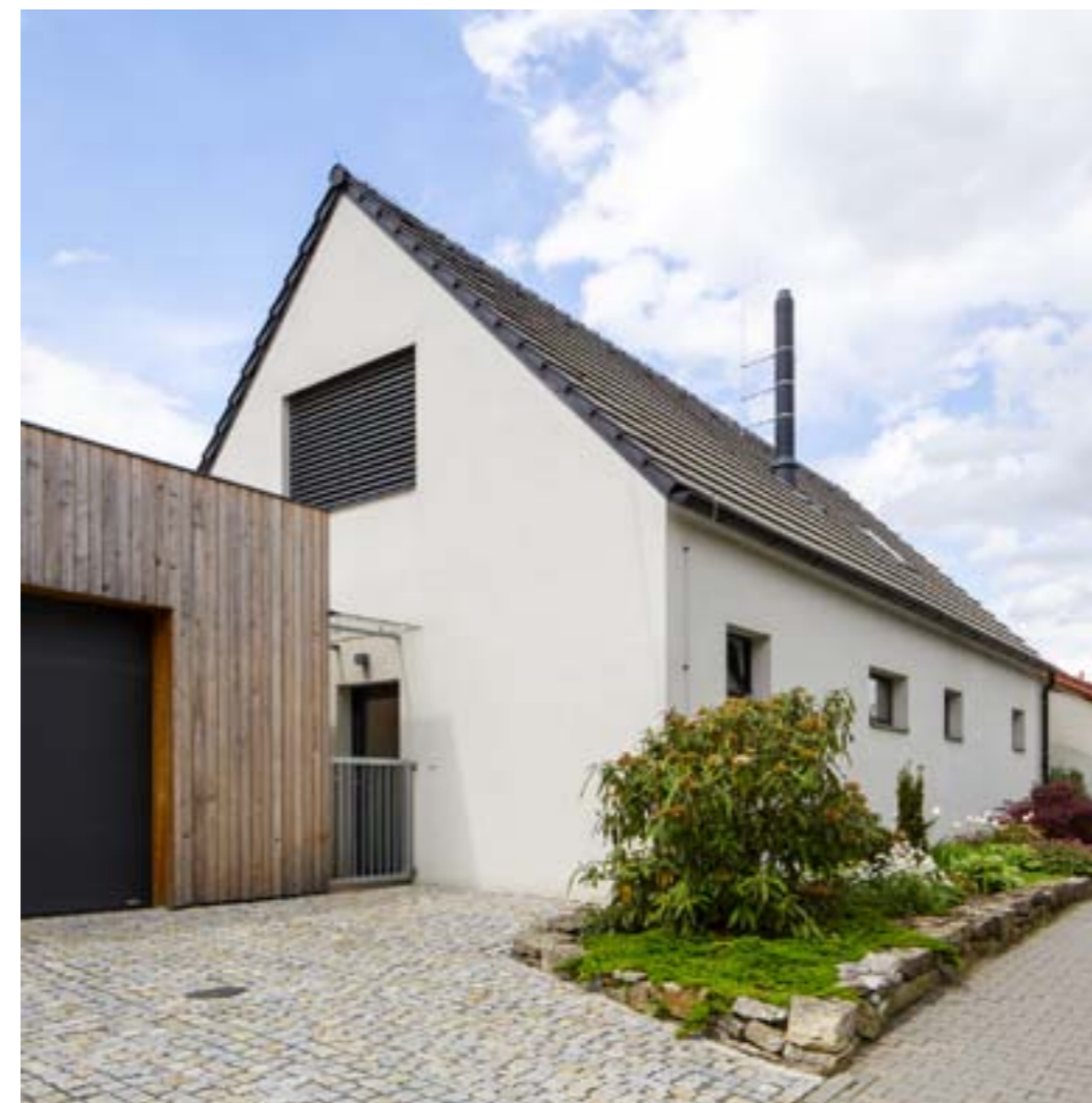
Do ulice se dům obrací tradiční fasádou s poměrně malými okny obslužných místností. Tento deficit vyrovnává pěkně upravená předzahrádka a garáž s dřevěnou fasádou
